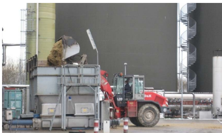
Annahmebehälter und Fermenter
