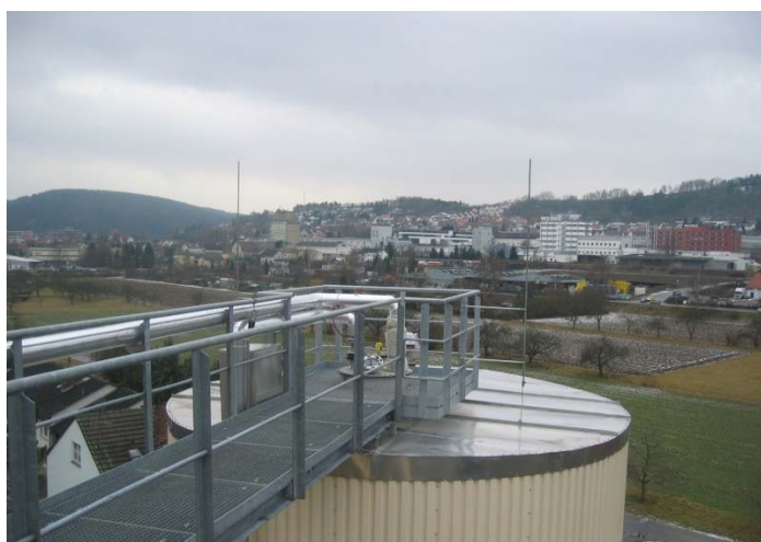
Dach des Hochleistungsfermenters
